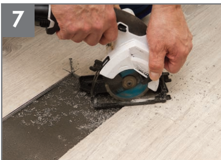
7 Corte cuidadosamente las diagonales. Aspire los desechos.
