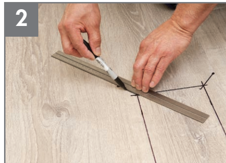
2 Marque los puntos de detención diagonales en las cuatro esquinas de la tabla dañada.
