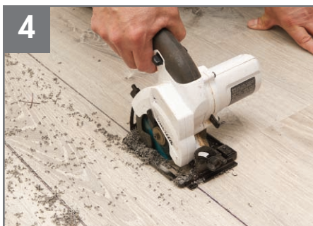
4 Corte cuidadosamente a lo largo de las marcas del perímetro que hizo. Aspire los desechos.
